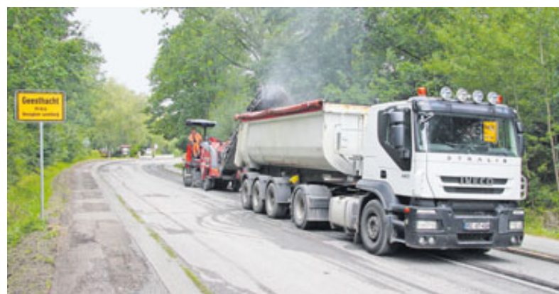
Mit einer Fräse wird die oberste Asphaltschicht abgetragen. Die Bauarbeiten bei Geesthacht laufen auf vollen Touren. Foto: Jann
