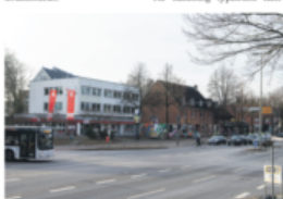
So sah die Ansicht über die Kreuzung Südkörner Landstraße/ Ecke Scheerfelder Landstraße vor dem Abriss aus
